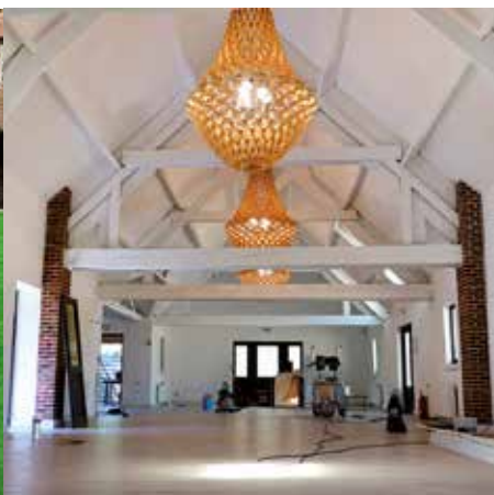
Les travaux s'achèvent dans la grande salle de réception.
